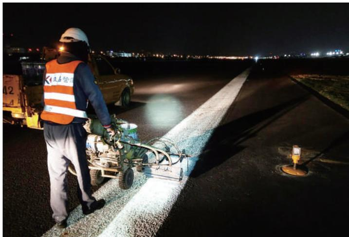
機場滑行跑道的標誌重繪也是機場維護員的工作之一，如此才能確保飛機起降的方向辨識和飛行安全。
