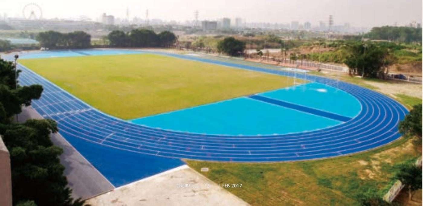
中正高中田徑場的施工過程相當繁複，包括刮除原跑道鋪面、壓實跑道底層超過 95% 的夯實度、重鋪瀝青混凝土鋪面、調整洩水坡度等多個步驟，最後再鋪上符合國際認證標準的合成橡膠鋪面，並以高壓磚壓密，以達平整、美觀的要求，每一個過程都不能馬虎。
