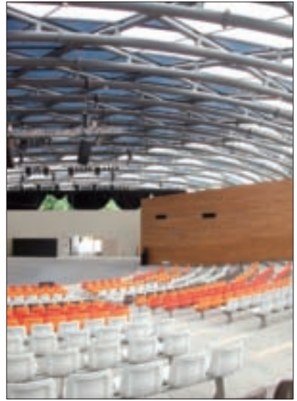
舞蝶館的鋼骨結構都可回收再利用，內部自然通風、自然採光。(顏涵正攝)
