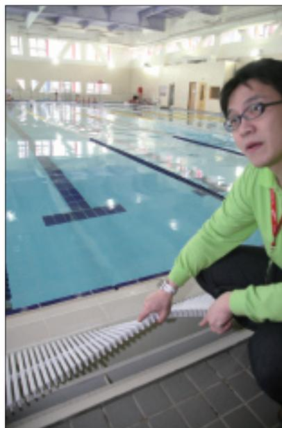
士林運動中心的游泳池排水孔加裝分隔板，用水過濾循環後可再回收使用。
