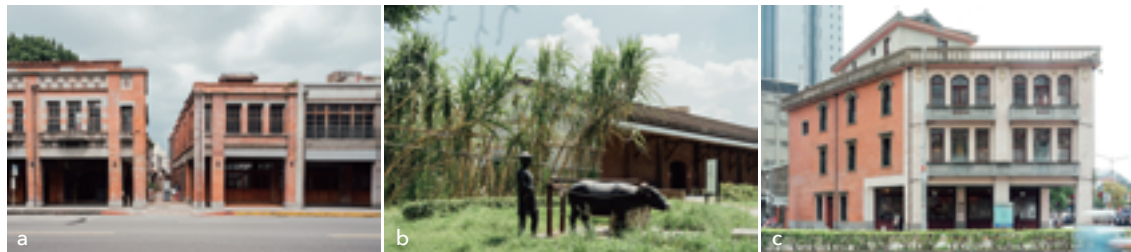
a. 剝皮寮的建築依然保有清代和日本時代的樣貌，彷彿凍結了時間。b. 糖廊文化園區內的甘蔗，提醒著後人，這裡曾是台北城內唯一的製糖所。c. 萬華林宅獨特的立面，還有3層樓外加頂樓神明廳的設計，顯見當時林家的社經地位。
