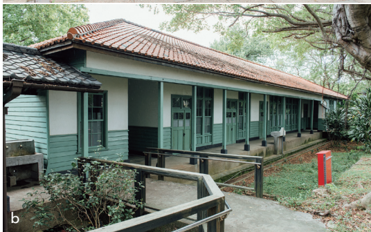
a. 北投文物館的枯山水庭園與「書院造」建築結構，讓人彷彿來到了小京都。b. 日本風味十足的綠色建築，是前日軍衛戍醫院北投分院的最大特徵，也是電視劇《一把青》的取景拍攝地之一。
