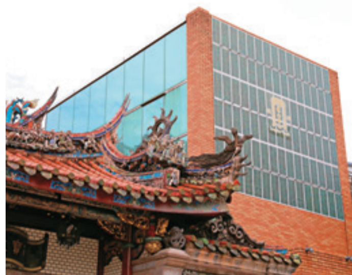
艋舺龍山寺行政大樓外牆裝設彩色直立式太陽能板。(攝影/蘇立坤)
