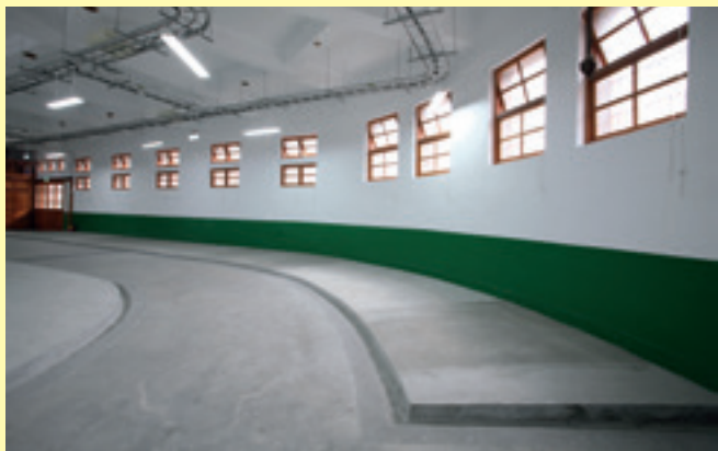
先進的排水溝渠設計，讓市場不會四處都溼答答。
